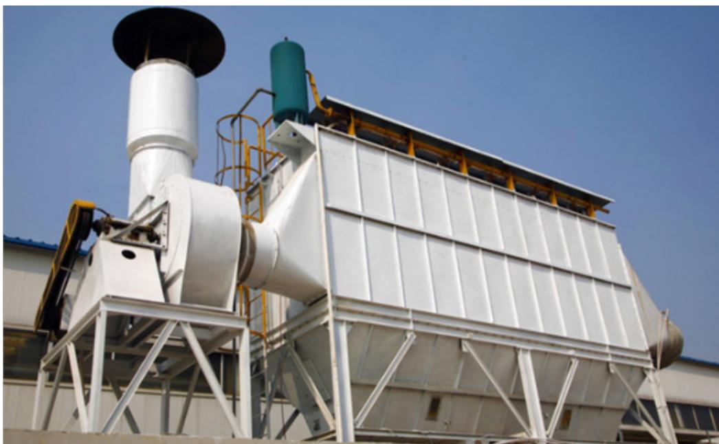
除尘设备-目前已比较广的应用于我国电力、水利、钢铁、化工等行业，为我国有效控制废弃物的排放量做
